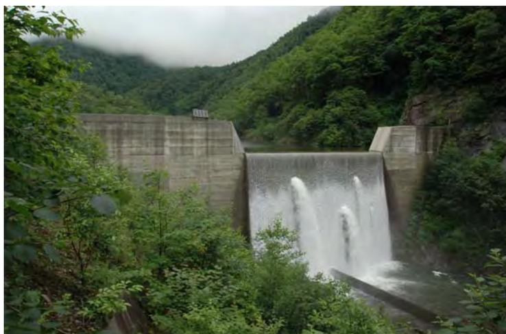
写真はトッタベツ川の源流・分水界まで7km地点の最上流部にある砂防ダムである。竣工は1991年。長さ82m、高さ21mで完全にトッタベツ川の流れを遮断している。背後のダム湖は築後20年の今も大きく深く、埋め立ては進んでいない。砂礫で埋められるから意味がある
