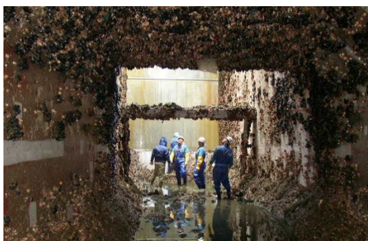
生物が付着した発電所の海水導入管（左）と船底（右）
