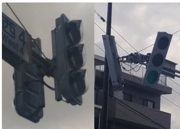
図 4 雪国仕様の LED 式信号機
